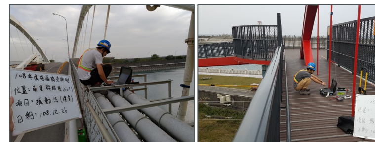
橋梁鋼纜預力量測
